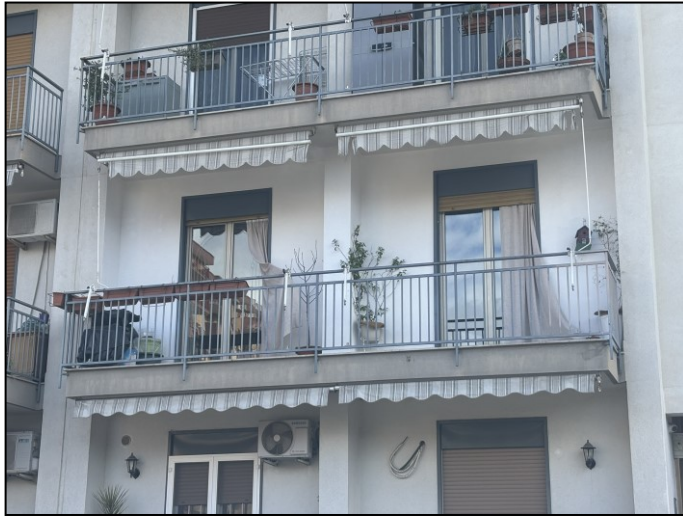
Foto 37 – Vista del balcone lato ovest
