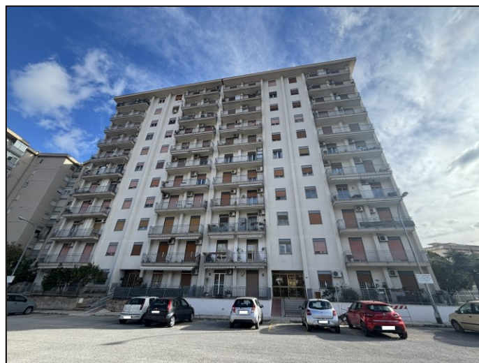
Foto 4 – Vista del prospetto ovest dell'edificio
